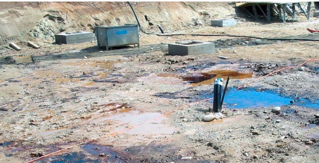
Bild 2: Kohlenwasserstoffaustritte (Erdöl) während der Erstellung des Geothermiefeldes der «Blumenbörse Rothrist». 2005 wurden in 70, 142 und 154 m Tiefe kleinere Erdöleintritte beobachtet. Das Geothermiefeld befindet sich heute unter dem Fundament der Blumenbörse.
