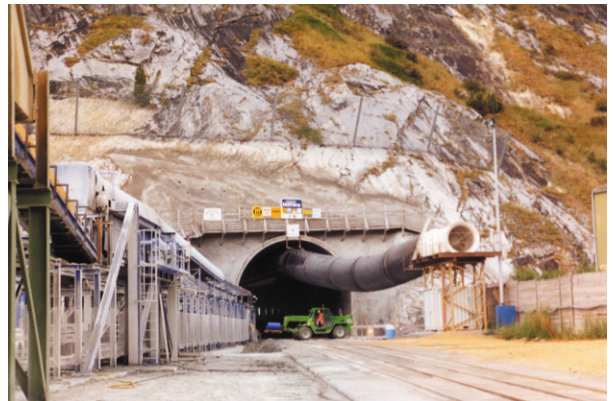
Basistunnel Lötschberg: Portal Niedergesteln in Steg, Wallis (Foto JW)
