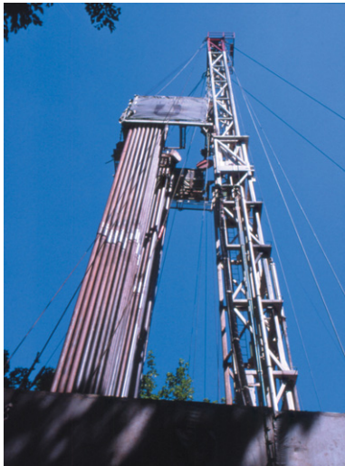
Sondierarbeiten an der Bohrung DHM-2 in Otterbach, Basel (Foto FDV)
