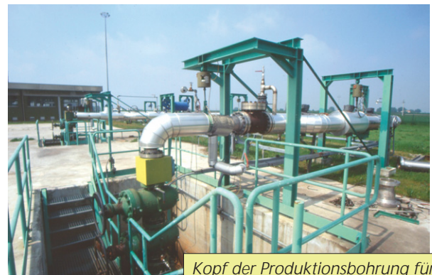
Kopf der Produktionsbohrung für das geothermische Fernwärmenetz in Ferrara (Foto O. Joswig).
