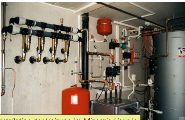
Installation der Heizung im Minergie-Haus in Bevaix. Links: Leitungsein- und -ausgang der beiden Erdwärmesonden (Foto F.-D. Vuataz)
