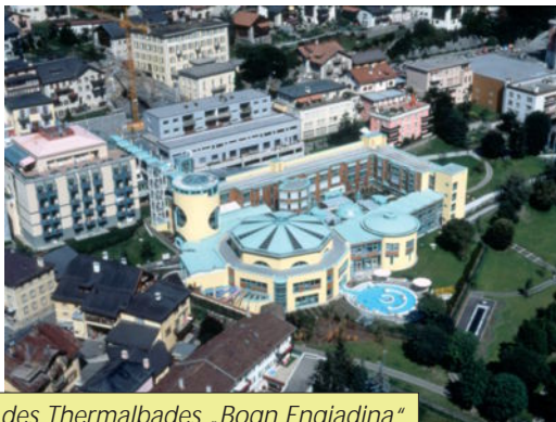
Ansicht des Thermalbades „Bogn Engiadina“ in Scuol. Das Erdwärmesondenfeld befindet sich unter der Grünzone rechts im Bild. (Foto Bogn Engiadina, Scuol)
